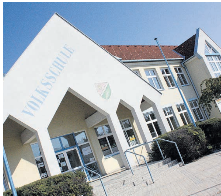
Das Volksschulgebäude wird um eine Etage aufgestockt. Ab September 2018 sollen die zwei weiteren Klassen nutzbar sein.
