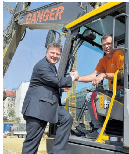
Die Bagger sind bereits angerollt. Auf den ehemaligen Hörbiger Gründen entsteht das neue Stadtquartier. Wohnbaustadtrat Ludwig beim Lokalaugenschein.
