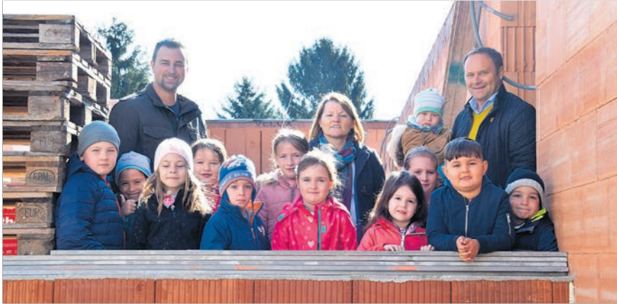
Die Freude auf den neuen Zubau beim Kindergarten I ist bei Groß und Klein riesig. Im September können zwei zusätzliche Gruppen einziehen. FOTOS: GEMEINDE
